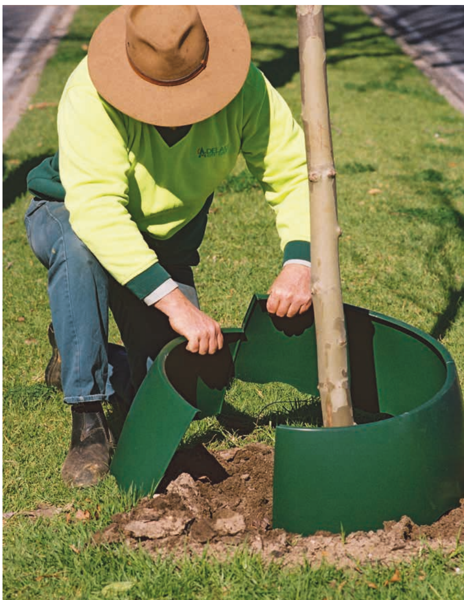
Der arboGreenwell ist formstabil und dank haltender und dichtender Zipverbindung kann er schnell installiert werden. | Foto: B. Measday
